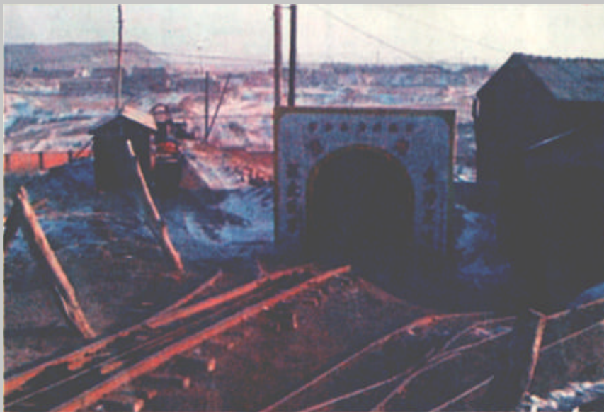
▲救援工作还在进行中。 ▲发生事故的煤矿矿井现场。
